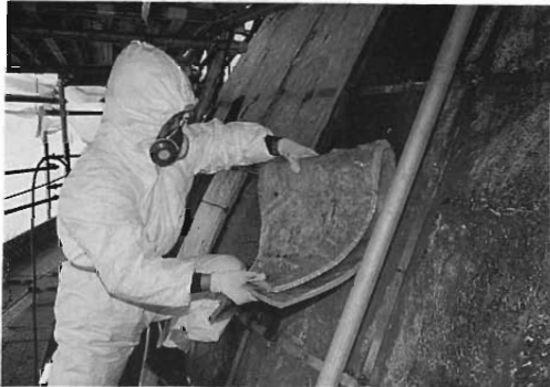
保温材撤去工事の状況
